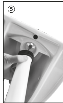
Inserire l'erogatore nel foro di entrata dell'acqua per lo scarico e l'ugello nel foro della ceramica
